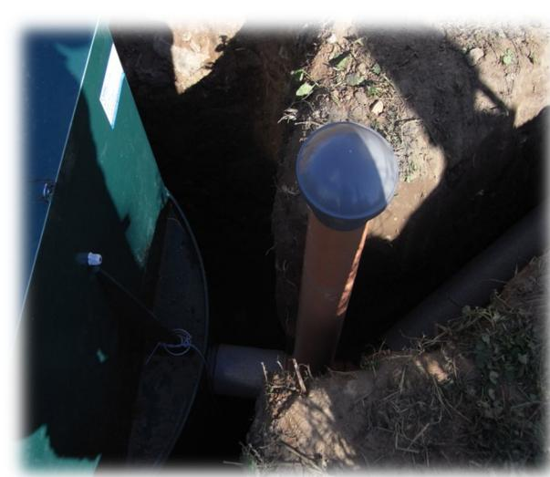
Уклон подводящей трубы должен составлять 10мм/м. Необходимо убедиться, что в подающей трубе отсутствуют «водные карманы», они могут нарушить нормальную циркуляцию воздуха в системе очистки.
